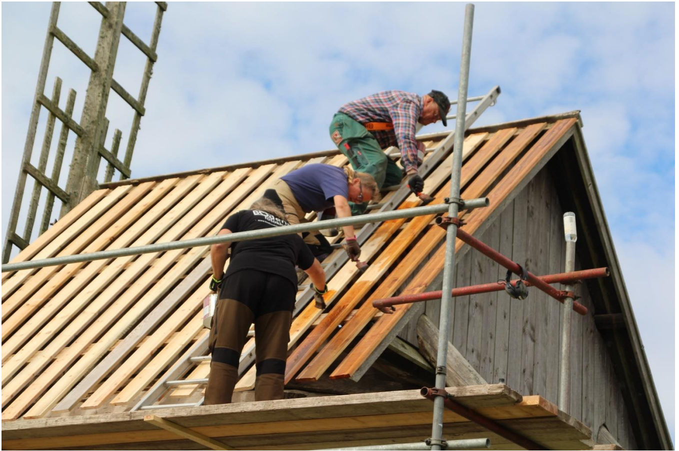
Behandling av underfalarna med tjärvatten....
