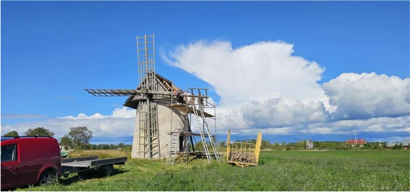
250825: Sedan ska det gamla taket av. Södersidan först (Foto: Andreas Fernandez Rosenke)
