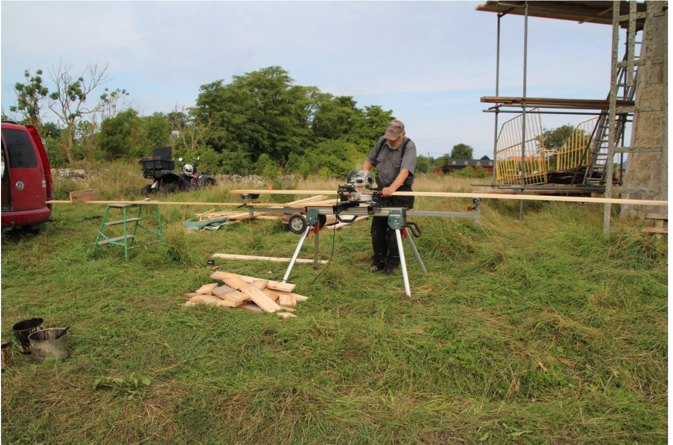
Nockbrädor ska sågas till
