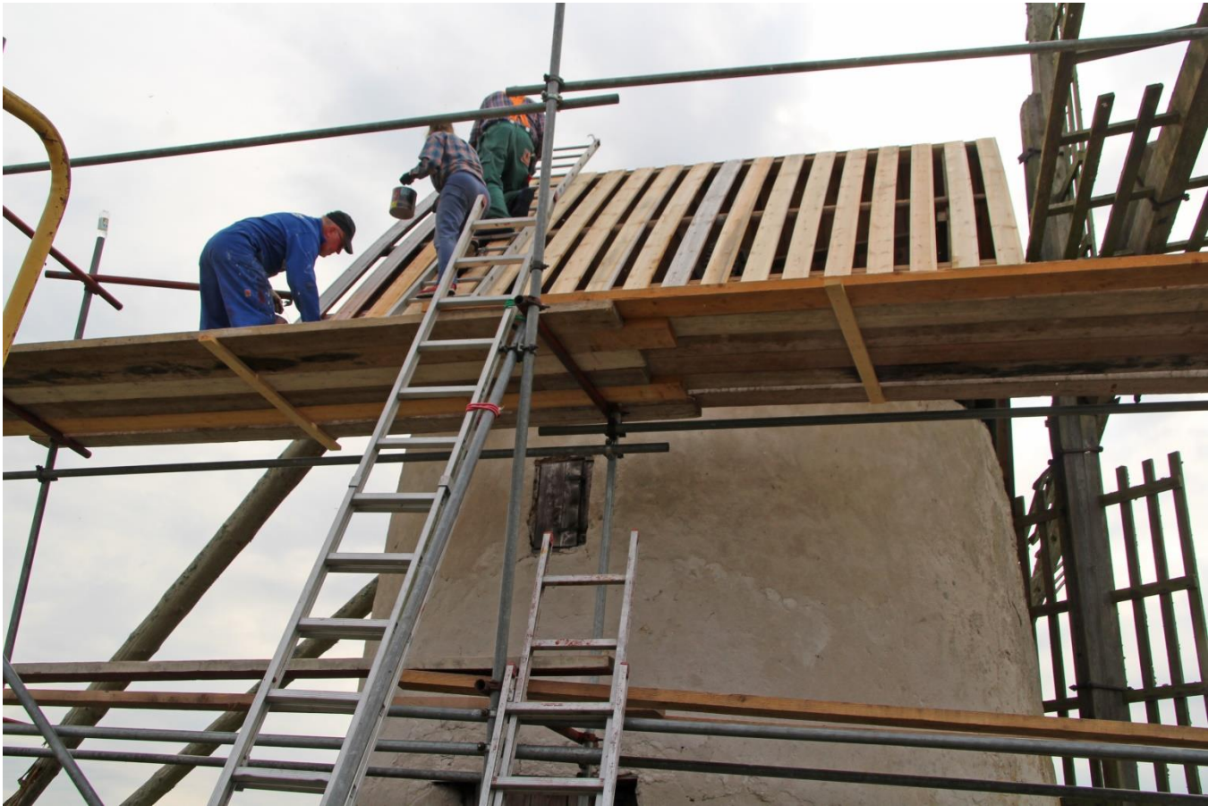
250828: Underfalarna på plats på norrsidan, behandling med tjärvatten kan börja
