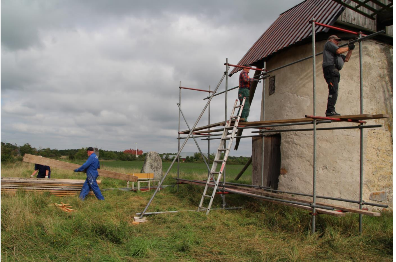
Dags att riva byggställning
