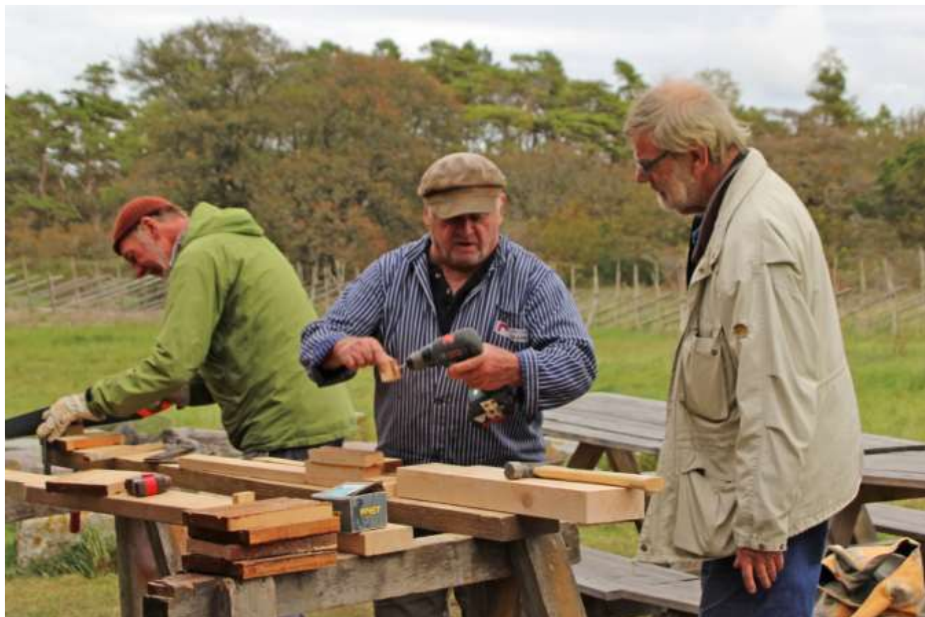
Tillverkning av små passbitar för tätning under/mellan takbrädorna
