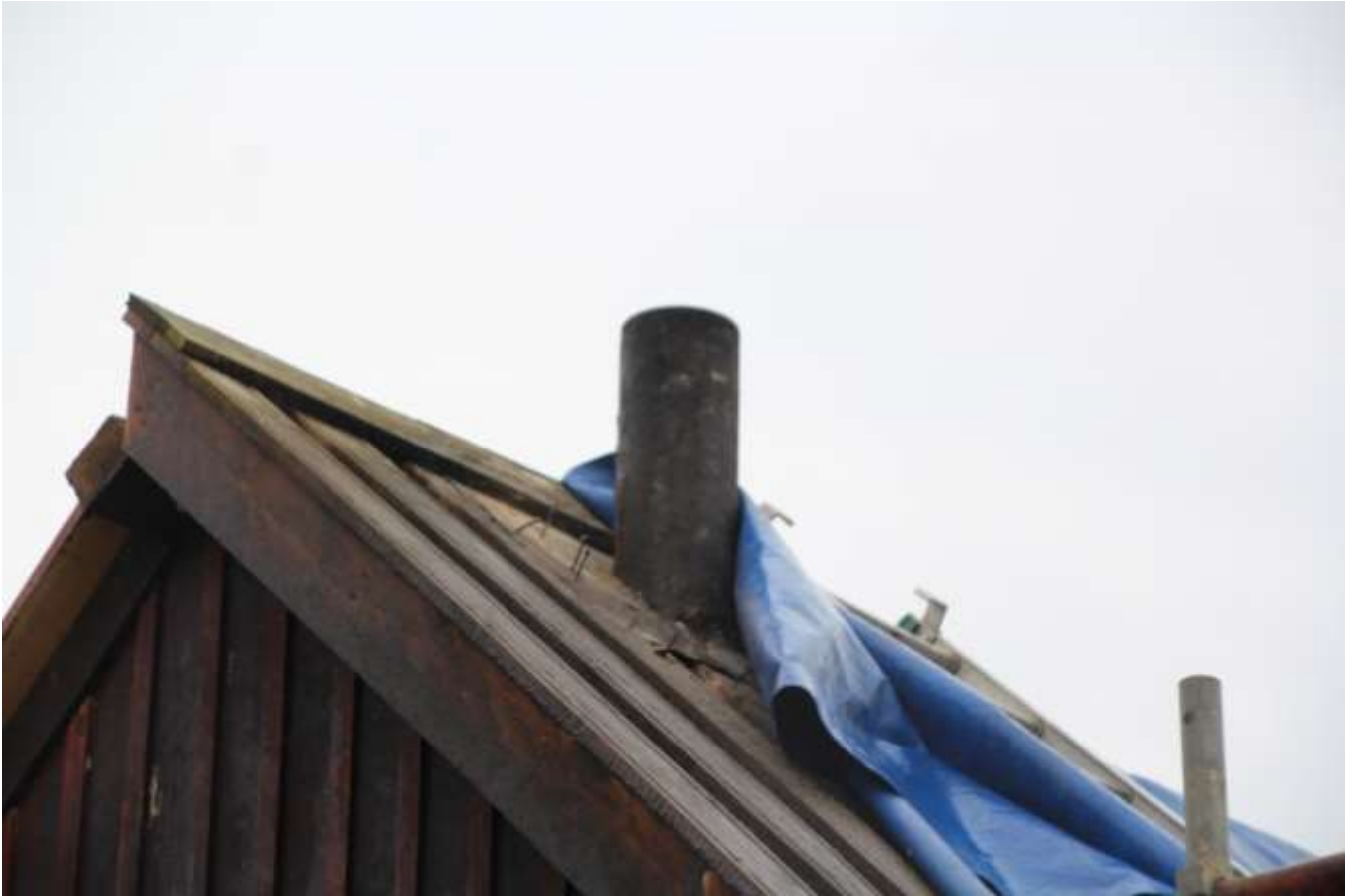
Även skorstenen i behov av renovering
