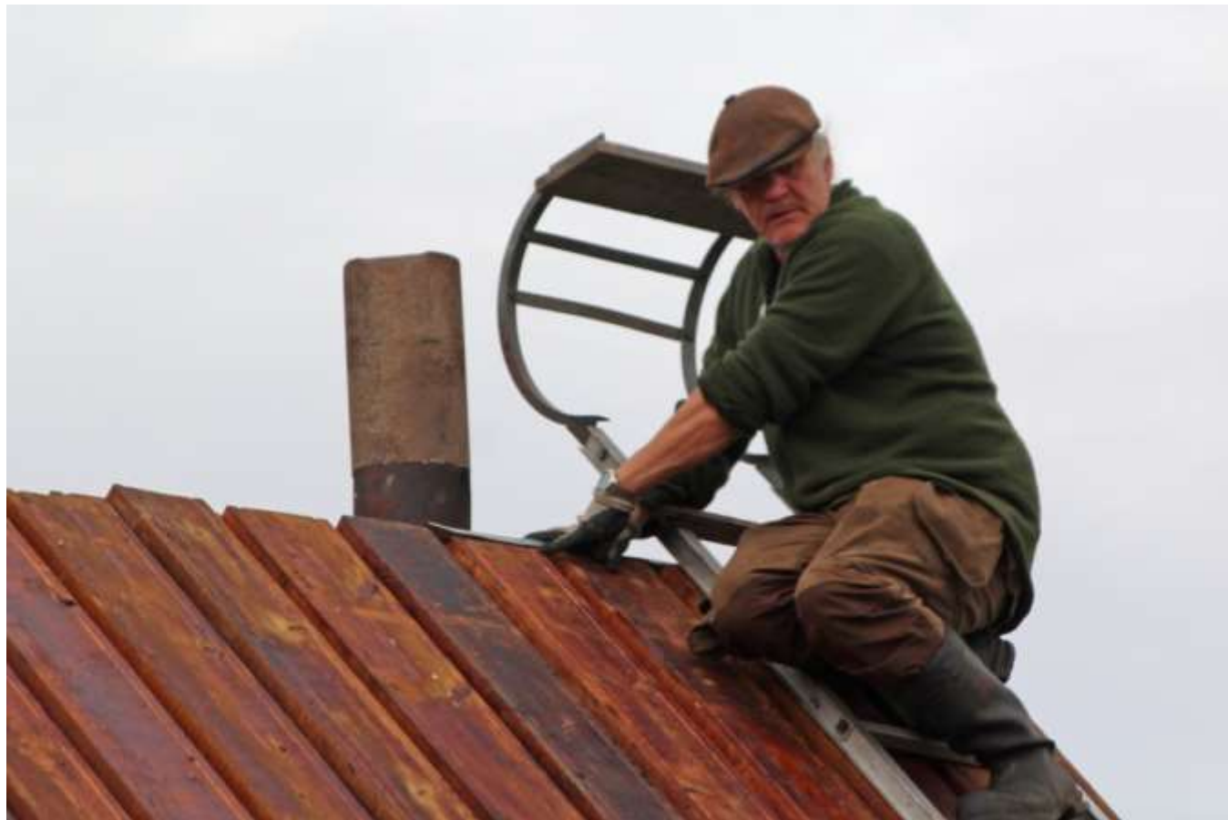
Skorstensröret behövde förlängas
