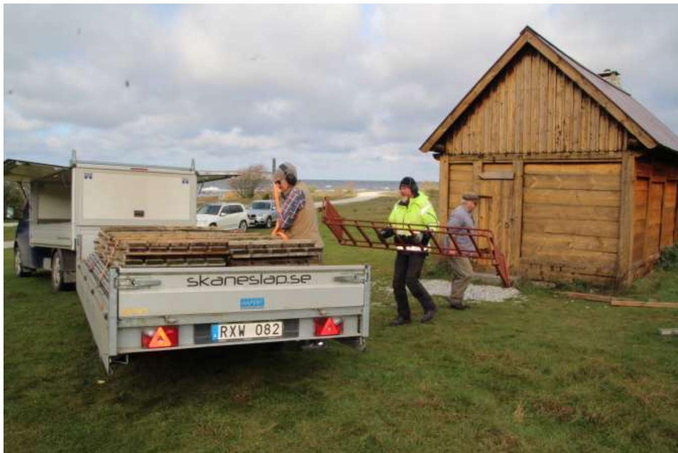
2021-10-11: Byggställningarna tas bort
