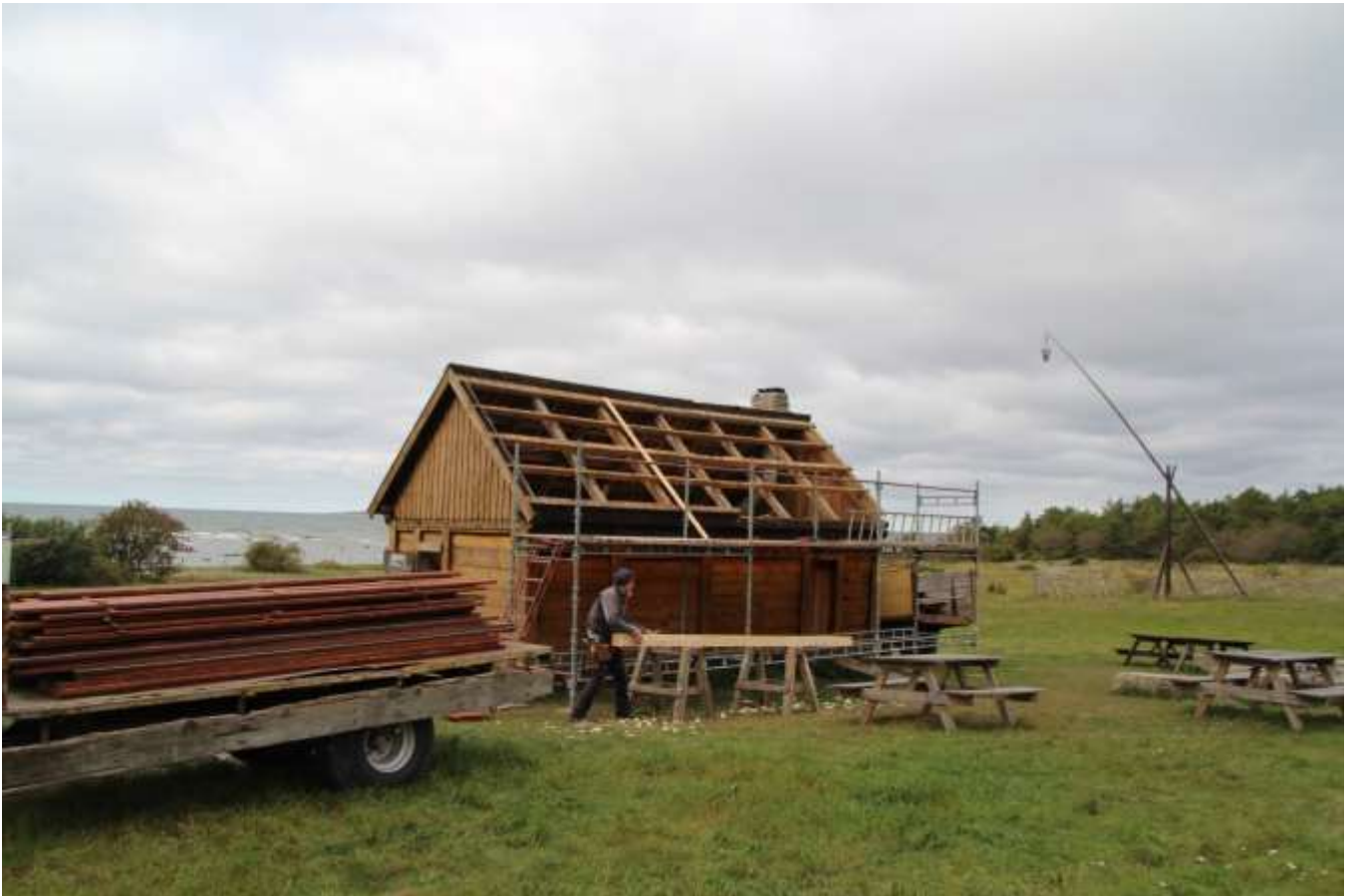
2021-09-13: En takhalva riven, förstärkning pågår
