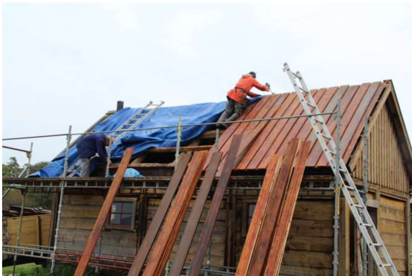
2021-09-16: Andra takhalvan påbörjad
