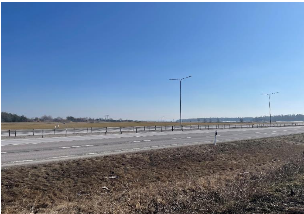
Figur 13. Vy mot sydöst över befintlig och planerad ledningsgata längs E4a:n vid Östra Fyrislund.
