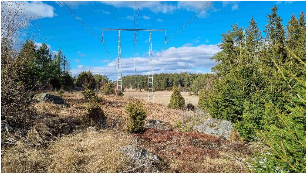
Figur 16. Befintlig ledning och planerad ledningsgata genom en skogbeklädd höjd omgiven av åkermark söder om Danmarks by.
