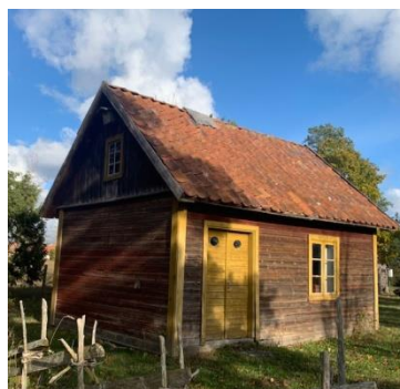
Stavens hus före flytt
