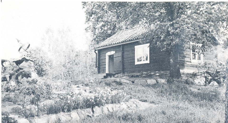
1945, lades nytt tak, reparerades ut- och invändigt.
