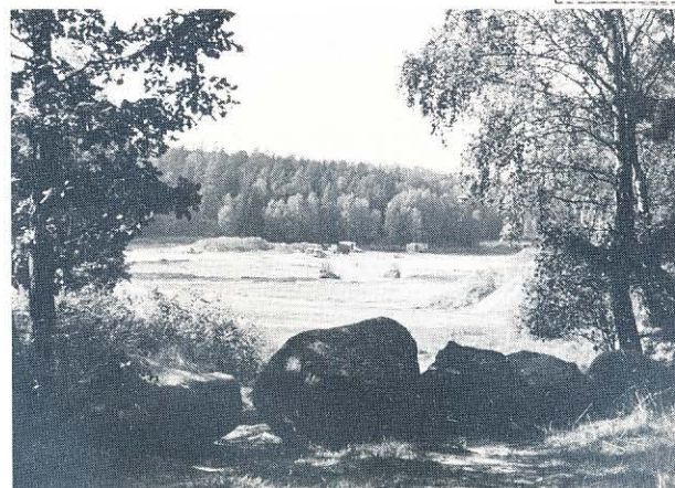
Slutharvat i Stora Dalen. Vid Stora Dalen schaktas åkerjorden bort för Lilla Dalens begravningsplats, nu invigd.
