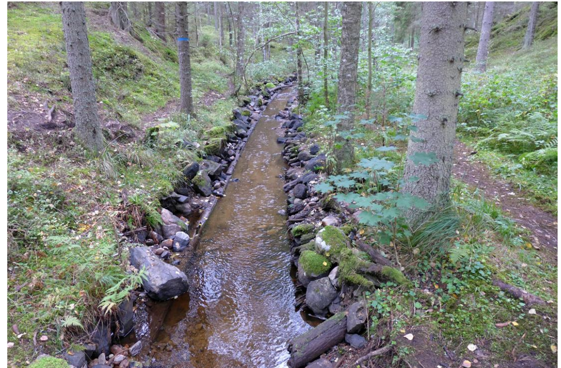
Lämningar efter en flottningsränna av trä i Granviksån, Karlsborgs kommun.
