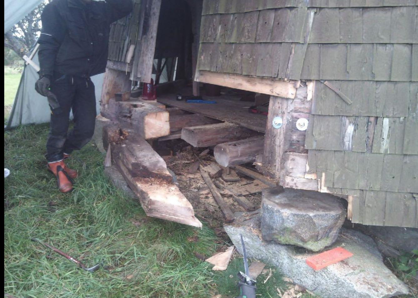
Syllarna på kvarnen var ruttna och byttes till halva varvet runt.
