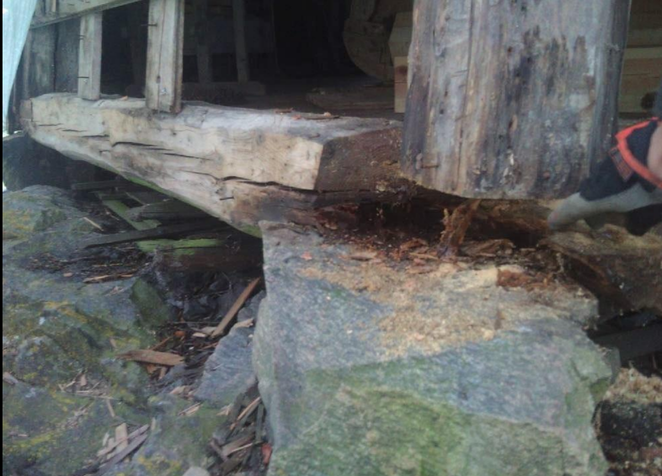
Syllarna på kvarnen var ruttna och byttes till halva varvet runt.
