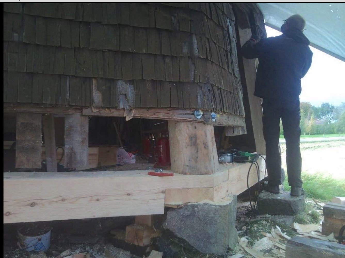
Syllarna på kvarnen var ruttna och byttes till halva varvet runt.
