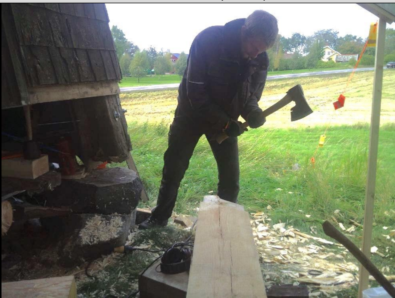
Syllarna på kvarnen var ruttna och byttes till halva varvet runt.
