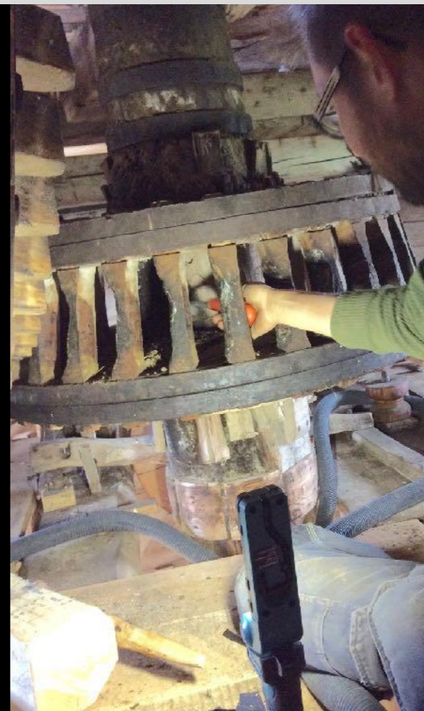
Kvarnmekanismen justerades för testkörning med den lilla gröpestenen för fodermjöl. Testkörning utfördes under våren 2017.
