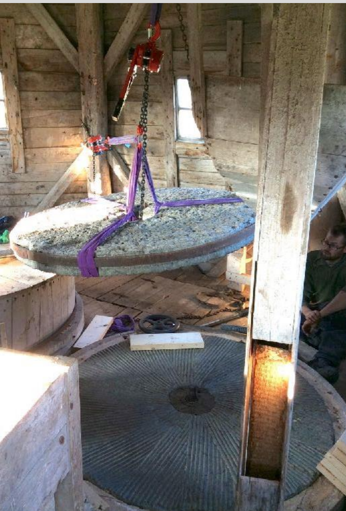
Kvarnmekanismen justerades för testkörning med den lilla gröpestenen för fodermjöl. Testkörning utfördes under våren 2017.
