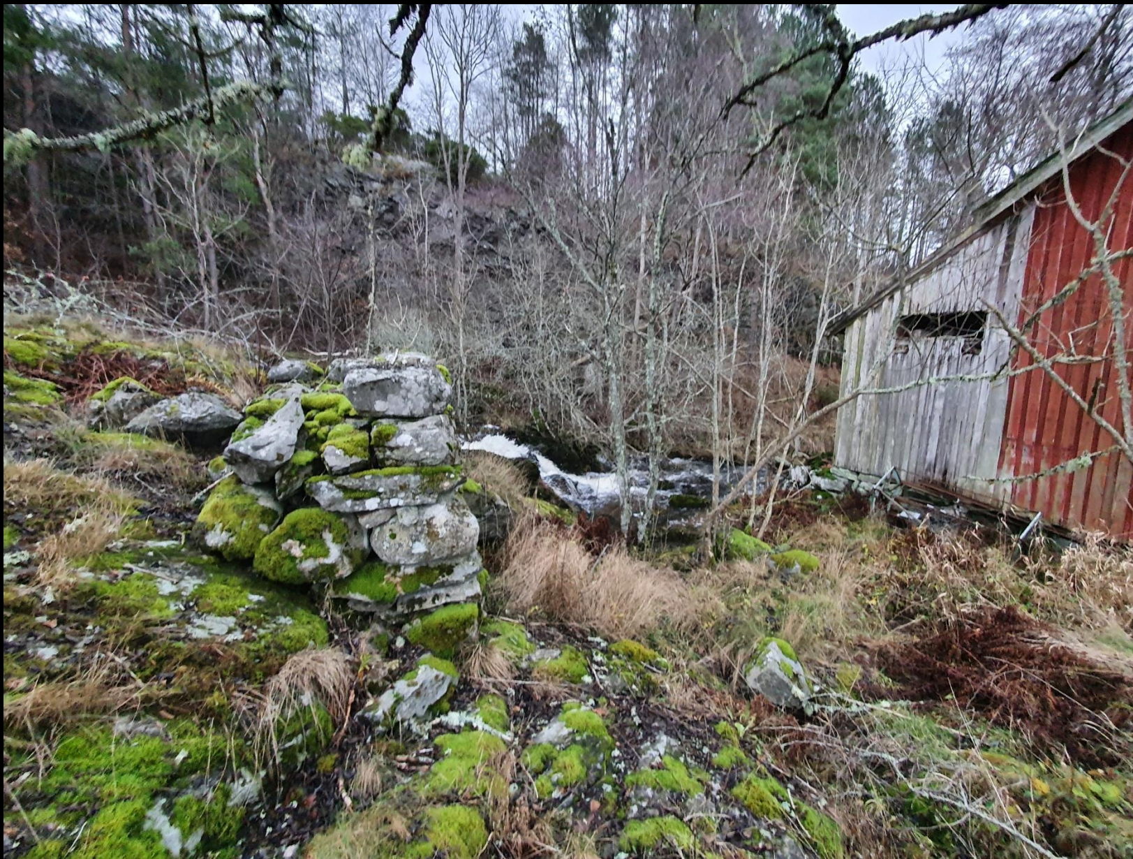
Stenfundament till vattenledare vid Långeby på Orust.
