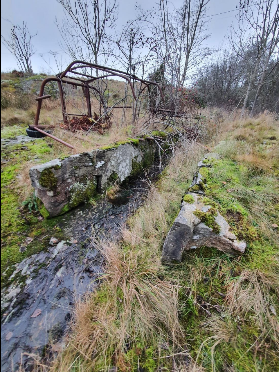
Vattenledare till vattenränna vid Långeby kvarn på Orust Till höger: Kvarnväg och stenplattebro till kvarn i Råttån, Skepplanda.
