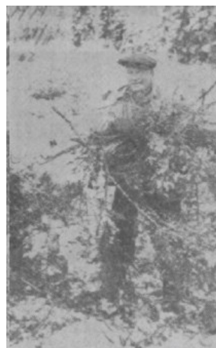
Hilding Eriksson, Flybäcken, sätter fyr i en rishög. Omfattande rensningar föregår arbetet med den nya vägen
