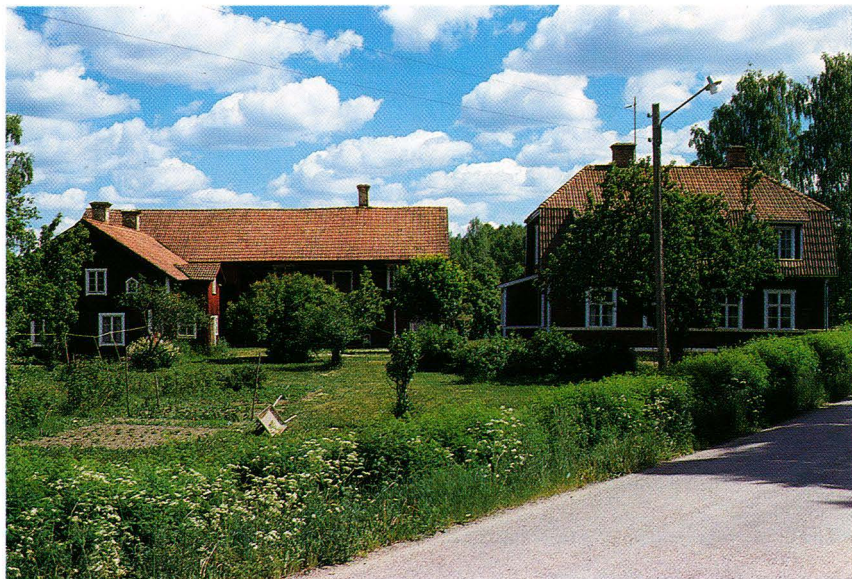
Nolmyrabro garveri är länets bäst bevarade garvargård och ett värdefullt exempel på en av de många mindre anläggningar som tillkom på landsbygden i slutet av 1800-talet för förädling av jordbrukets produkter. Foto: Håkan Liby 1984.
