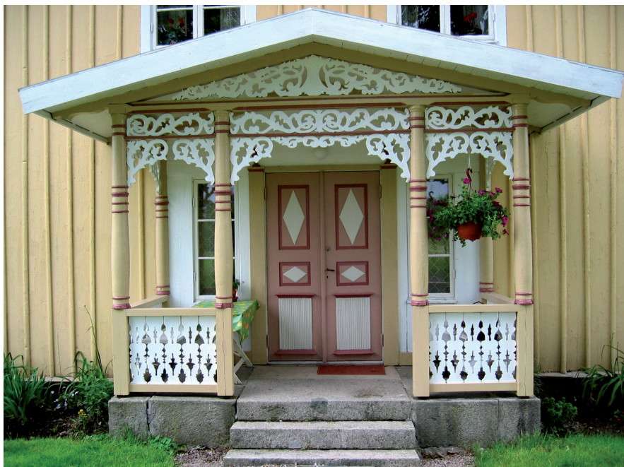
Johan Petter har gjort veranda med snickarglädje i Sörskog mellangård. Där bodde hans dotter Selma med sin man och fem barn från 1930. Den ägs idag av Selmas barnbarn Cecilia Zadig
