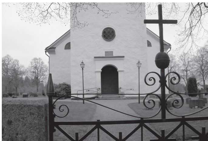
Kyrkdörren är låst och stängd sedan oktober 2009. Betydande mögelangrepp i golvbjälklaget är orsaken.
