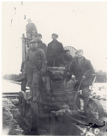
Stenkross med sorteringsverk som användes vid vägbygget. Högst upp ses Ture Andersson, Bredhult.
