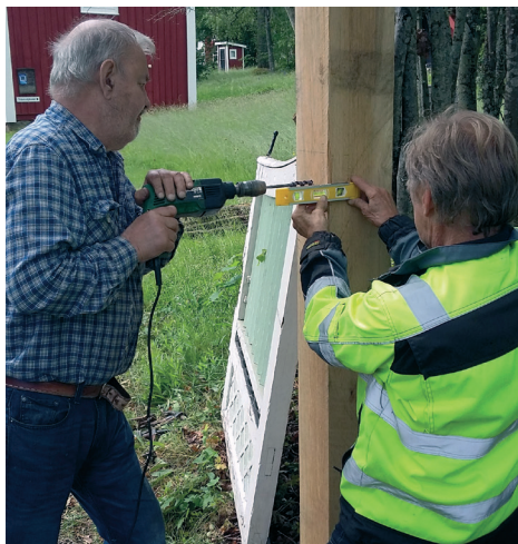
Nils-Allan Johansson och Olle Åström arbetar med håltagning för gångjärn. Ett precisionsarbete.
