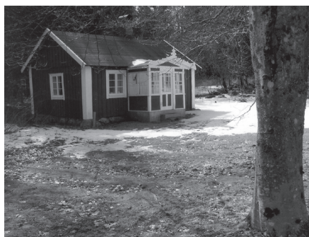
Stugan vid Bokedal revs tyvärr under hösten. Orsaken var svåra rötskador.
