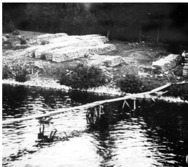
Vid lastning av ved och props rallade man ut lastenen med en skottkärra, en s.k. räv till fartyget, som låg på djupare vatten.
