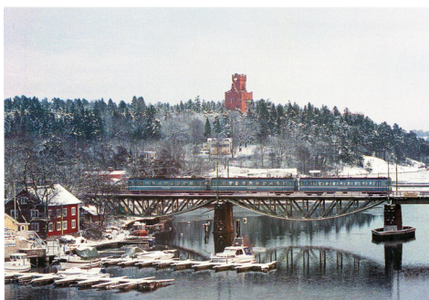
Järnvägsbron som byggdes 1884–1885. Ultraförlaget, foto Mikael Röhr,
