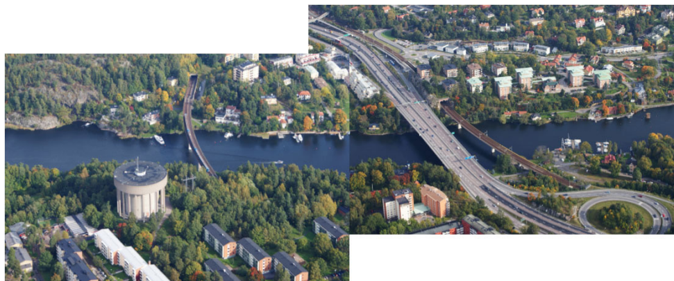
Dagens broar. Från vänster: Tunnelbanebron, motrovägsbron, nya järnvägsbron och en brope-lare från den rivna gamla järnvägsbron. Foto: Jan Ainali.
