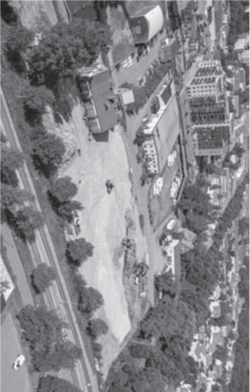
Markarbetena för den nya brandstationen, Österstationen, har just kommit igång. Gatan framför hyreshusen leder till vänster fram till Willlys stora parkering. Foto NA:s fotograf.
