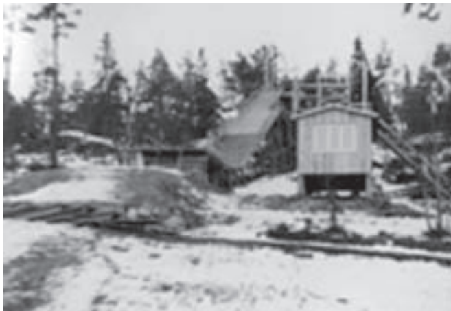
Tornet till hoppbacken färdigt 1935 (?). Värmestuga med plats för domare på taket.
