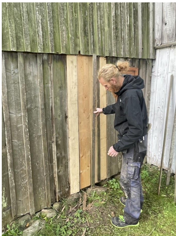
På norra sidans yttervägg ersätts ruttna och trasiga granbrädor med nya brädor i samma träslag.
