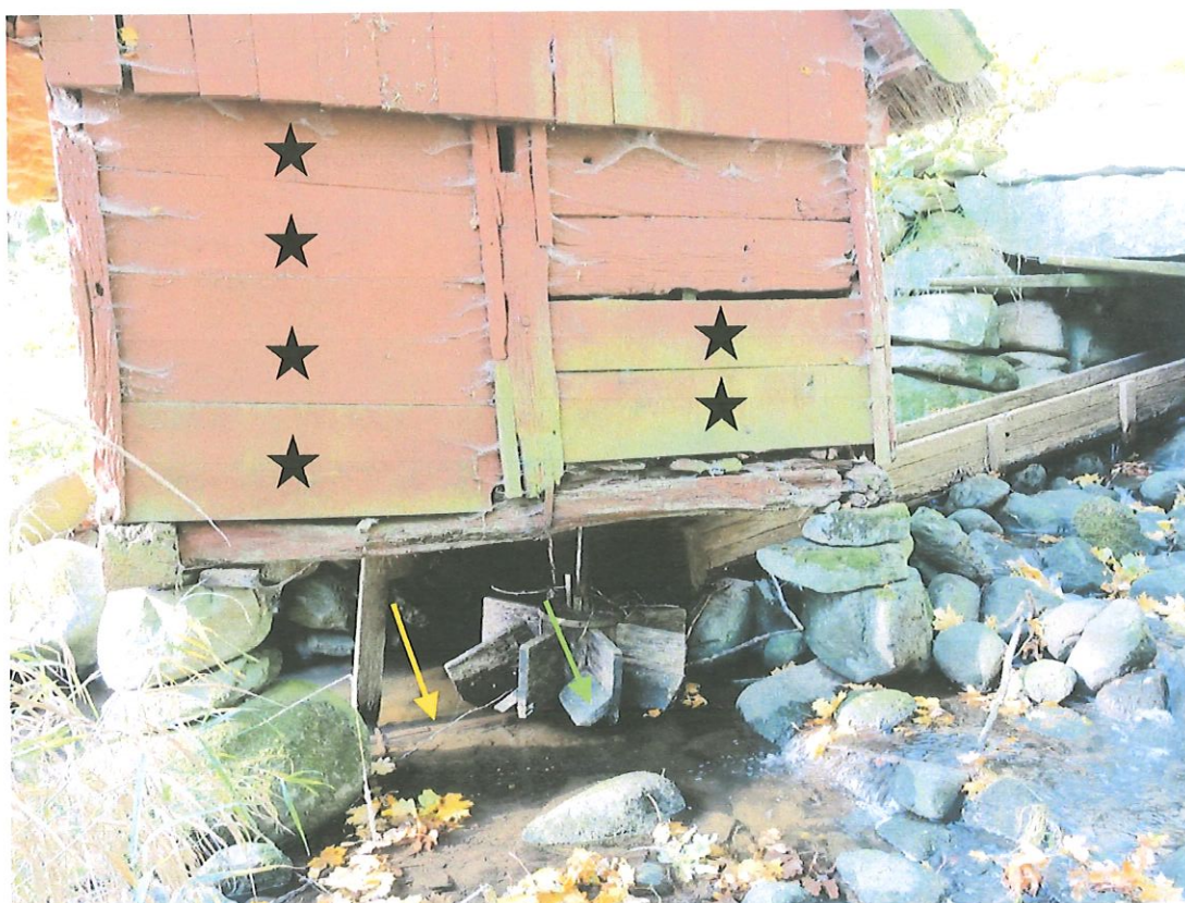
Skovelhjul och ränna. Den gula pilen pekar på skovelhjulets "fotträ". Grön pil pekar på sekundärt monterad "vinge" på ett av skovelbladen. Plankor med svarta stjärnor ersattes med ek, från skåttilljunga sågverk, på 00-talet. Foto MH.
