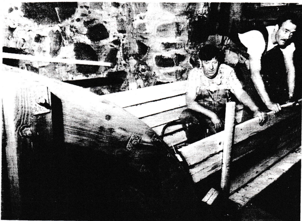
Bert Nordin och Ingemar Svensson bygger en ny träränna i Krubbemölla. Söndagen den 17 augusti släpps vattnet på.
