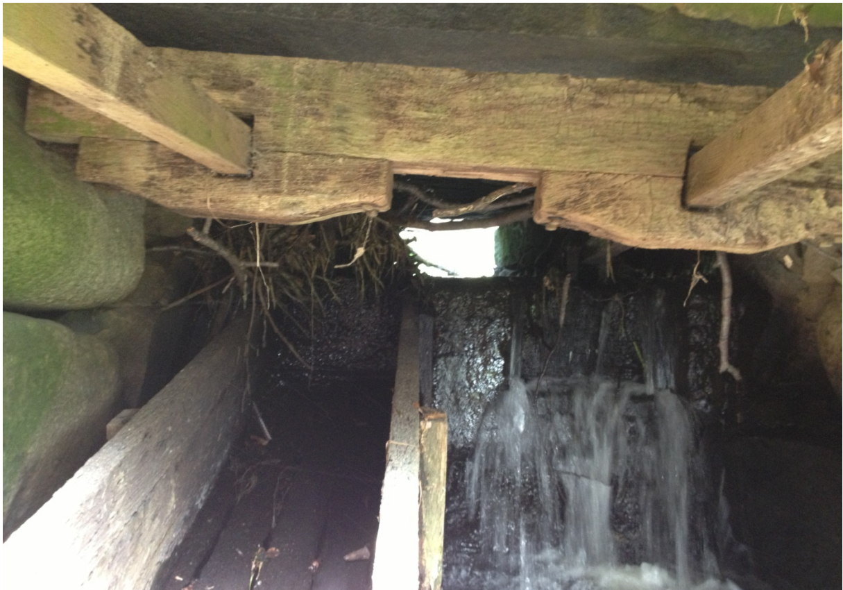
Dammlucka och ränna under dammvall/äldre vägbank
