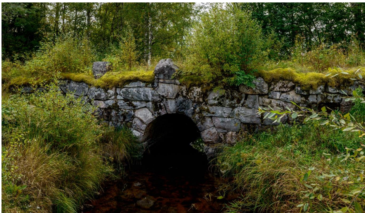
F d väg över Hälgnäsbron. Foto: Ingvar Åslund
